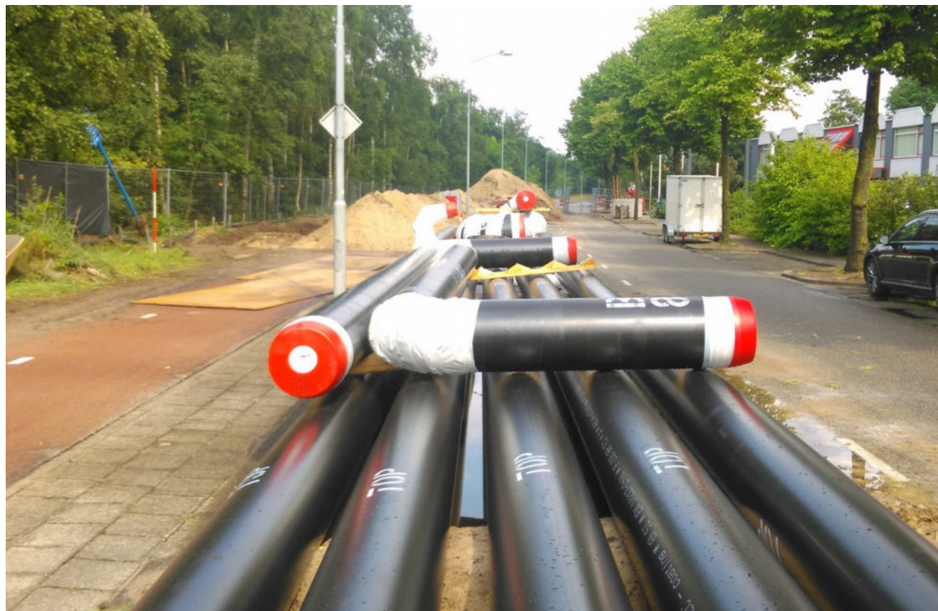
Aanleg van warmtenet (foto: Warmtebedrijf Ede)
